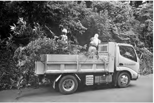
高所作業の様子
